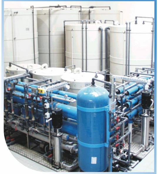
利用 ZLD 技术净化和回收飞机部件生产过程中产生的废水。
