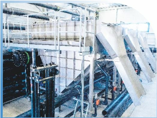
Tratamiento tipo ZLD de aguas residuales de una fábrica de vidrio con el reciclaje del agua.
