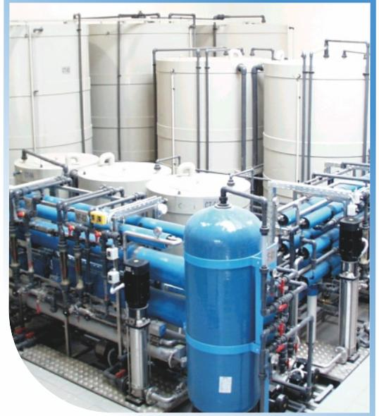
Tratamiento de las aguas residuales generadas en la producción de piezas de aviones y su reciclaje al proceso.
