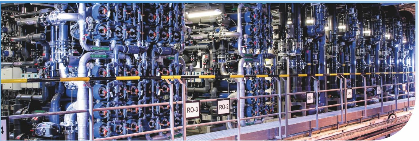
Construcción completa de un sistema de producción de agua de proceso desmineralizada, instalado en contenedor para una planta química.
