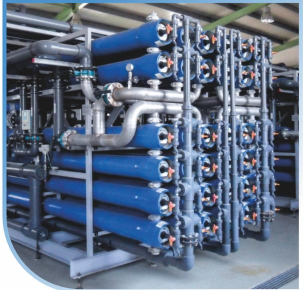
Construcción integral de un sistema de producción de agua de proceso desmineralizada a partir de agua superficial para la producción de materia prima de caucho.
