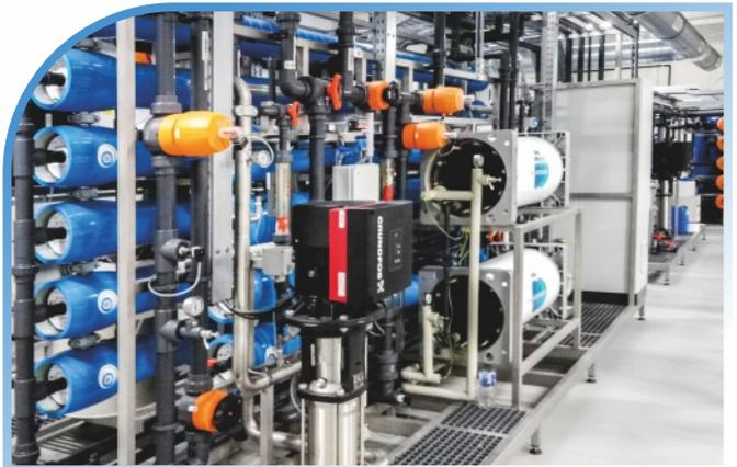
Construcción completa de un sistema de producción de agua de proceso desmineralizada para una central eléctrica.
