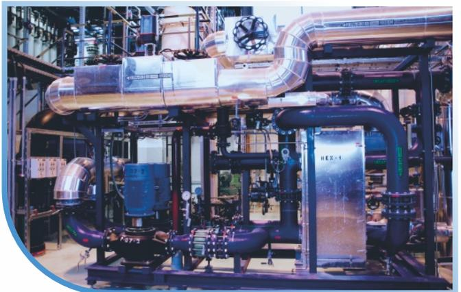
Producción de agua de alimentación auxiliar en una planta de calefacción con la dosificación de un producto químico de acondicionamiento, utilizando agua de pozo y agua condensada, para un proveedor de calefacción urbana.
