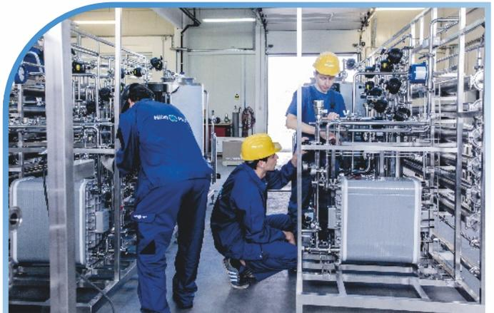
Construcción de un sistema de producción de agua purificada de calidad HPW de la farmacopea.
