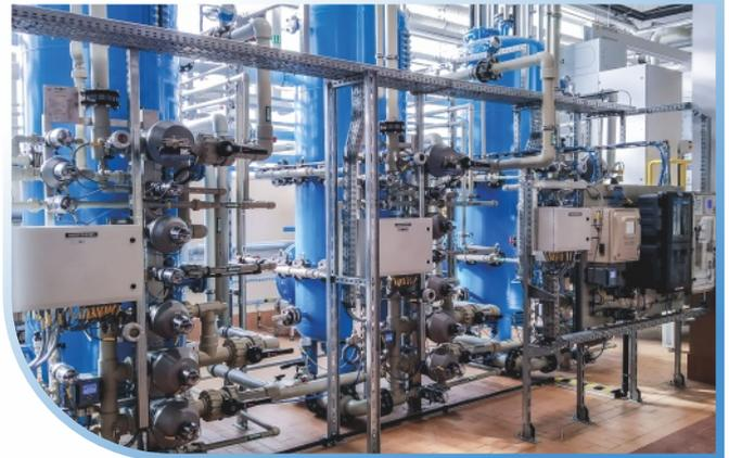
Diseno y realización de un sistema de producción de agua de proceso para uso energético a partir de agua de mar pretratada.
