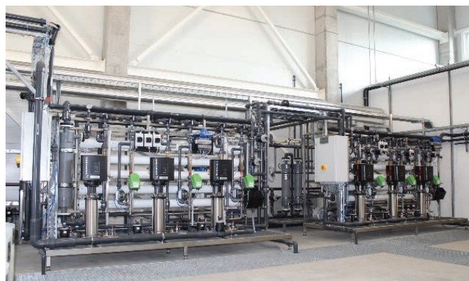
7. kép. Soros és párhuzamos kapcsolásban is működtethető RO berendezések
