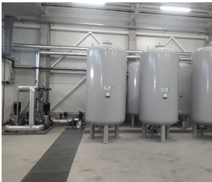
9-10. kép. Nyomástartás szivattyúi és a kiegyenlítő tartályok
