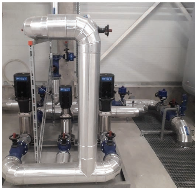
9-10. kép. Nyomástartás szivattyúi és a kiegyenlítő tartályok
