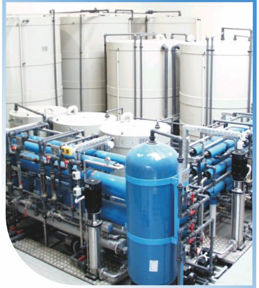
Lentokoneen osien valmistuksesta syntyvän jäteveden puhdistus ja kierrätys ZLD-tekniikalla. GE Aviation Hungary Ltd. / Unkari 100 m 3 /päivä
